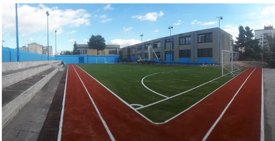
Fig. 6 Napoli, Ponticelli, Istituto Scolastico Eduardo De Filippo, fase di ultimazione dei lavori di riqualificazione [archivio fotografico privato antoniodimaro&Partners]
